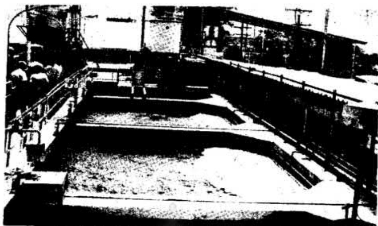
รูป 22 บ่อพักน้ำเสียในกระบวนการ "Activated sludge"
