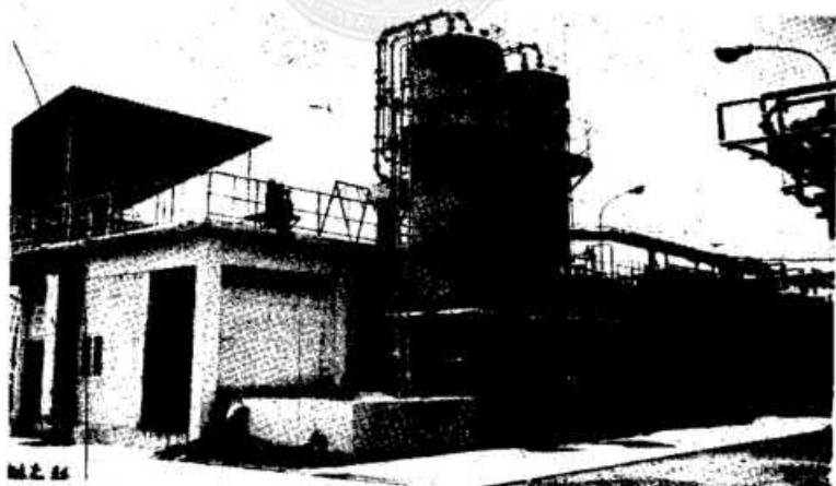
รูป 23 ส่วนหนึ่งของหน่วยกำจัดน้ำเสียในโรงงานผลิตผงชูรส ถังกลมสูงทั้งสองถังที่เห็นคือคอลัมน์บรรจุผงถ่านที่ใช้กรองน้ำในขั้นสุดท้าย
