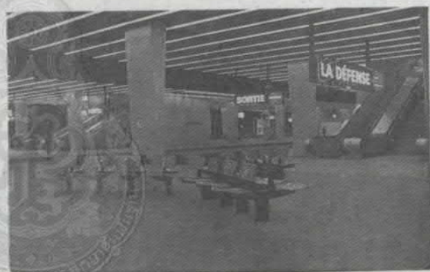
4 Une station très moderne
