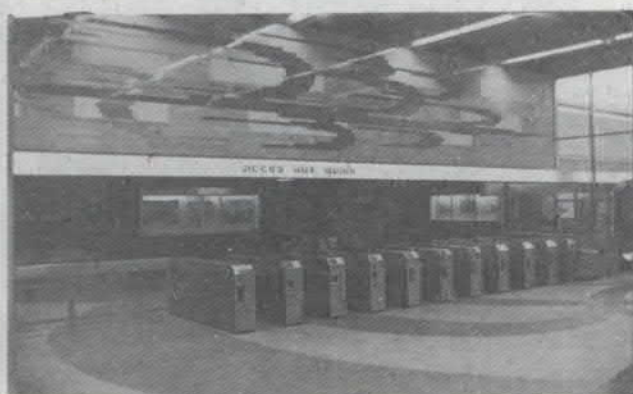
2 Accès aux quais : les poinçonneuses magnétiques
