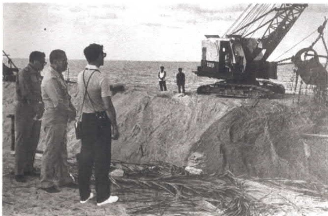
ทอดพระเนตรการขุดคลองปล่อยน้ำเสีย แก่พระบาทสมเด็จพระเจ้าอยู่หัว ทรงเสด็จ อำเภอเกาะช้าง จังหวัดตราด
