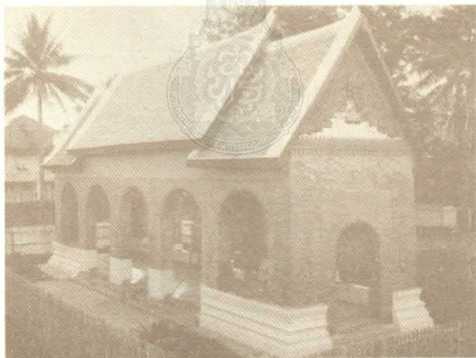
ศาลาโถง วัดมณีนิมมาวาส สงขลา ก่อสร้างด้วยระบบประตูและหน้าต่างโค้งดี ทำให้เป็นอาคารโถงที่อากาศถ่ายเทได้มาก
