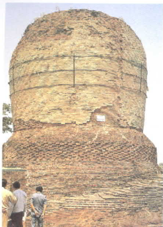
เจดีย์นาเวณะดอง ส่องผ่านดิน ไหวซีเรตมา กตมอเสาเทสิกรัดไว้
