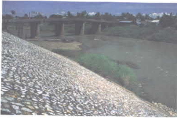
เขื่อนป้องกันน้ำเซาะตลิ่ง บริเวณแม่น้ำยม ด้านหลังของวัดสว่างอารมณ์วรวิหาร
