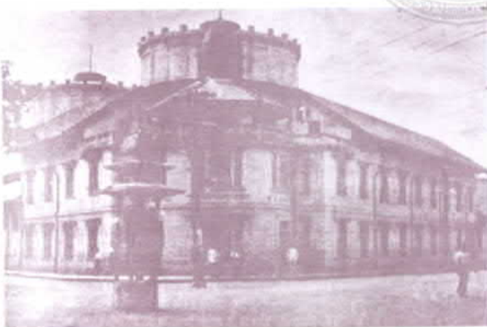
ถังสูงส่งน้ำประปาที่สี่แยกวรจักร
