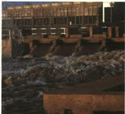
โรงงานที่ผลิตไฟฟ้าที่ปล่อยระบายน้ำร้อน ภายหลังจากการนำน้ำหล่อเครื่องจักร
