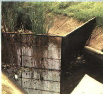
การใส่ตะแกรงกรองเศษขยะมูลฝอยก่อนระบายลงสู่คลอง
