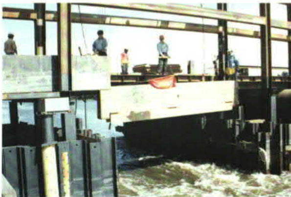
ประตูที่ใช้ระบายน้ำลงสู่ทะเลเพื่อป้องกันน้ำท่วม
