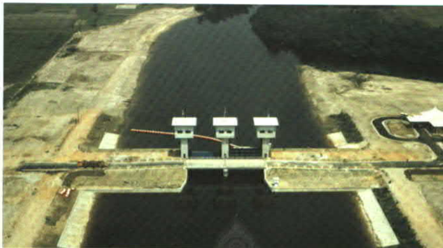
ประตูระบายน้ำเขื่อนบางลางคอนล่าง
