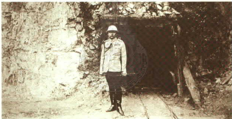
เจ้าพระยาวงศาสุรประพัตร์เสนาบดีกระทรวงคมนาคม ตรวจงานการก่อสร้างอุโมงค์ขุนตาล เมื่อ พ.ศ. ๒๔๕๕
