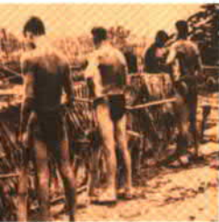
สภาพห้องน้ำกลางแจ้งบริเวณค่ายเชลยศึก
