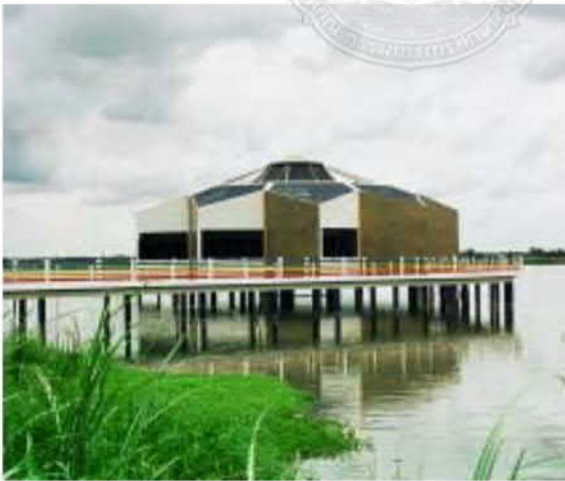
ศาลาเก่าเหลี่ยม ศูนย์แสดงพันธุ์ ปลาน้ำจืดบริเวณ ริมบึงสีไฟ
