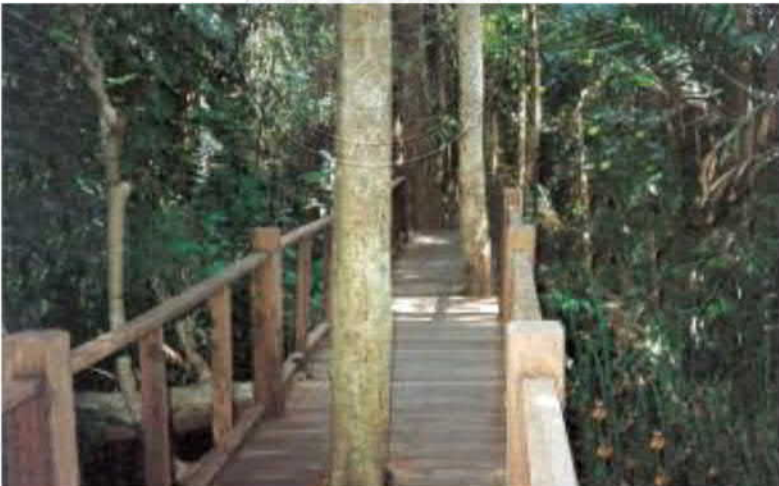
การสร้างสะพานผ่านป่า ที่ไม่มีการตัดต้นไม้ที่กีดขวางเส้นทาง
