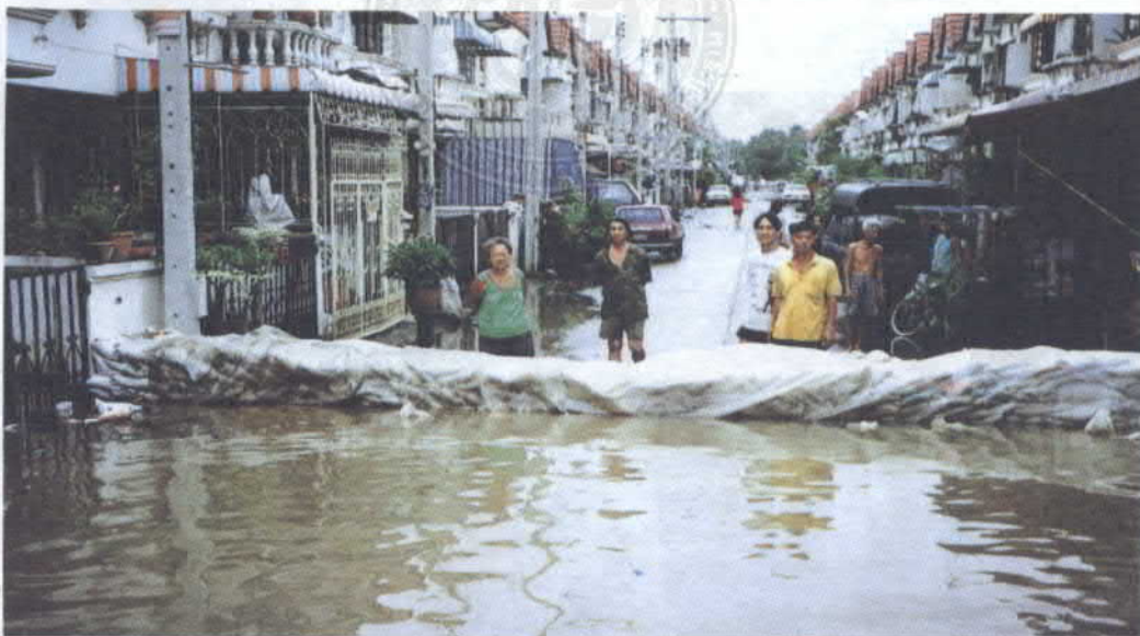
การใช้กระสอบทรายกันป้องกันน้ำเข้าท่วมอาคาร บ้านเรือน เป็นการลดความสูญเสีย
