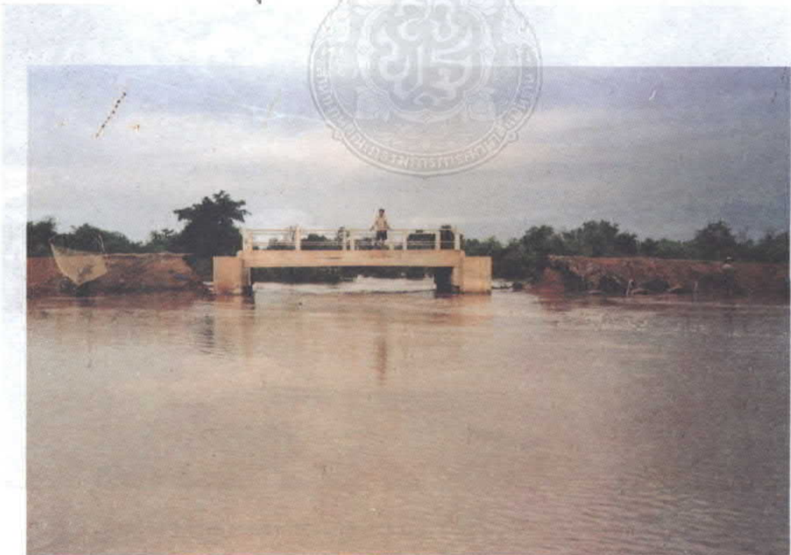
คอสะพานขาดเนื่องจากกระแสน้ำเชี่ยวไหลกัดเซาะพังทลาย
