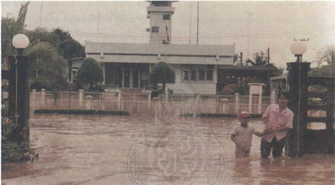
อุทกภัยทำให้น้ำท่วม ถนน อาคาร บ้านเรือนได้รับความเสียหาย
