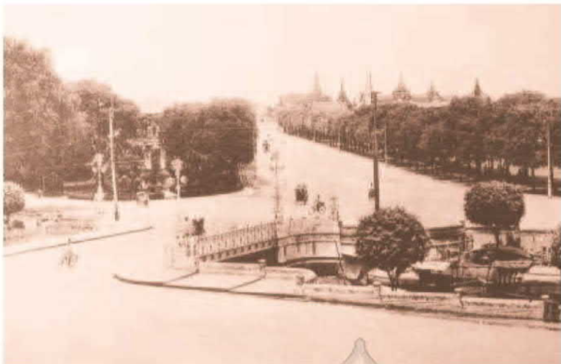
สะพานผ่านพิภพลีลาที่ถนนราชดำเนิน สร้างขึ้นในรัชสมัยพระบาทสมเด็จพระจุลจอมเกล้าเจ้าอยู่หัว
