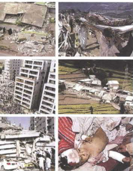
อาคารบ้านเรือนเสียหายและ ผู้คนบาดเจ็บหลังเกิดแผ่นดินไหว อย่างรุนแรง
