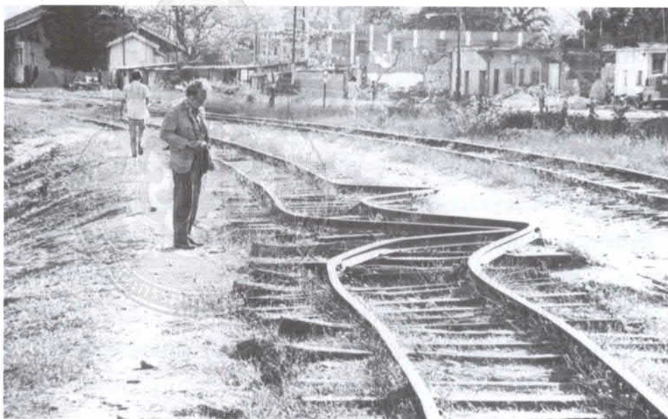
ทางรถไฟอยู่ในสภาพบิตองหลังเกิดแผ่นดินไหวอย่างรุนแรง
