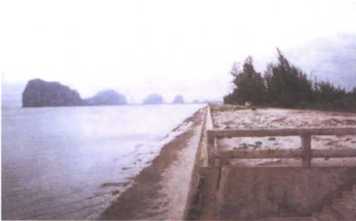
แนวกันคลื่นชายฝั่ง บริเวณหาดปากเมง อำเภอสิเกา จังหวัดตรัง ในลักษณะ กำแพงคอนกรีตเสริมเหล็ก มีหินทั้งด้านหน้า (ที่มา : หนังสือ “การเปลี่ยนแปลงพื้นที่ชายฝั่งด้านทะเลอันดามัน” ของ กรมทรัพยากรธรณี)
