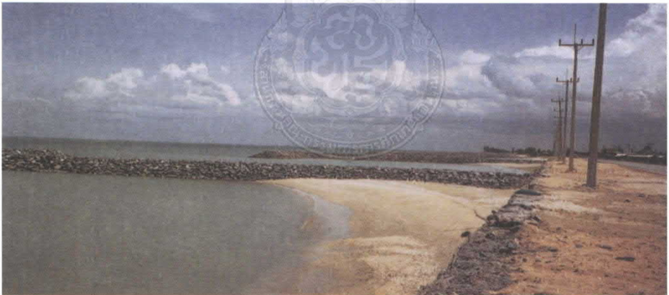
สภาพการแก้ไขปัญหาการกัดเซาะชายฝั่ง บริเวณเกาะผ้าย อำเภอบางพลี จังหวัดนครศรีธรรมราช ในลักษณะของการทำรอดักทราย เป็นกำแพงหินกันคลื่น (ที่มา : หนังสือ “กรมทรัพยากรธรณี ปีที่ ๑๑๑” ของกรมทรัพยากรธรณี)
