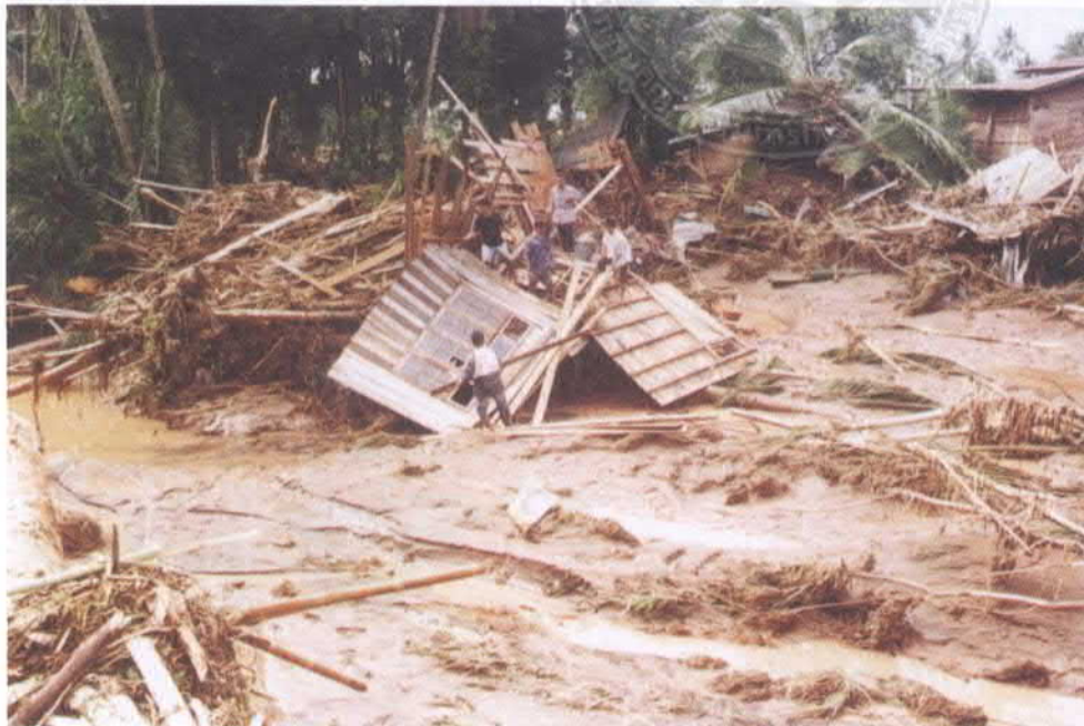
สภาพความเสียหายของ บ้านเรือนหลังจาก ประสบอุทกภัย (ที่มา : กรมทรัพยากรธรณี)
