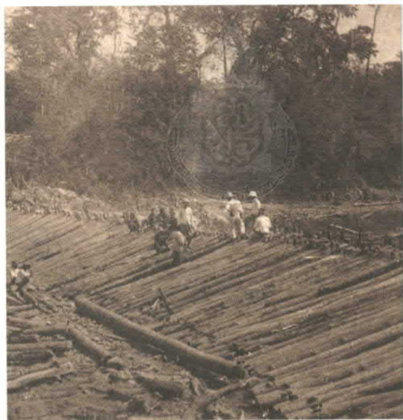
การก่อสร้างฝายกั้นลำน้ำสา จังหวัดน่าน
