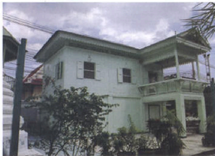
อาคารเก่าภายในวัด
