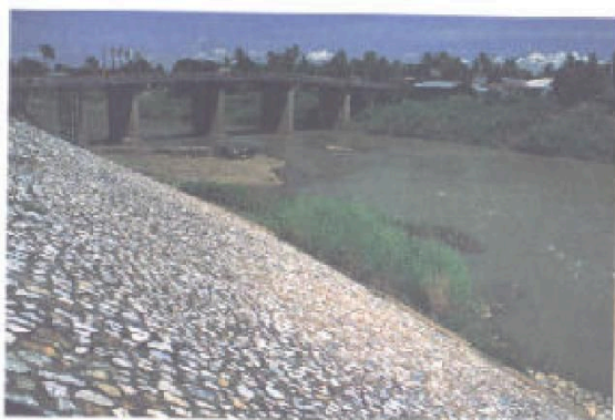
เขื่อนป้องกันน้ำเซาะหลัง บริเวณแม่ไถยม ด้านหลังของ วัดสว่างอารมณ์วรวิหาร
