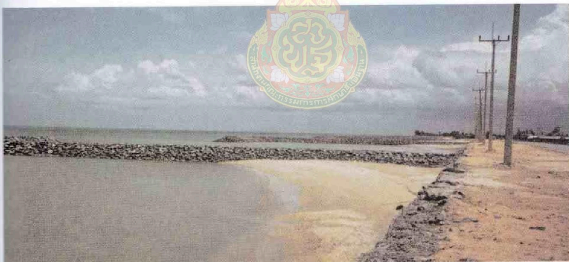
สภาพการแก้ไขปัญหากัดเซาะชายฝั่ง บริเวณเกาะฝ่าย อำเภอปากพนัง จังหวัดนครศรีธรรมราช ในลักษณะของการทำรอดักทรายเป็นกำแพงหินกันคลื่น (ที่มา : หนังสือ "กรมทรัพยากรธรณี ปีที่ ๑๑๑" ของกรมทรัพยากรธรณี)
