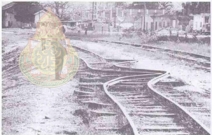
ทางรถไฟอยู่ในสภาพบิดงอหลังเกิดแผ่นดินไหวอย่างรุนแรง
