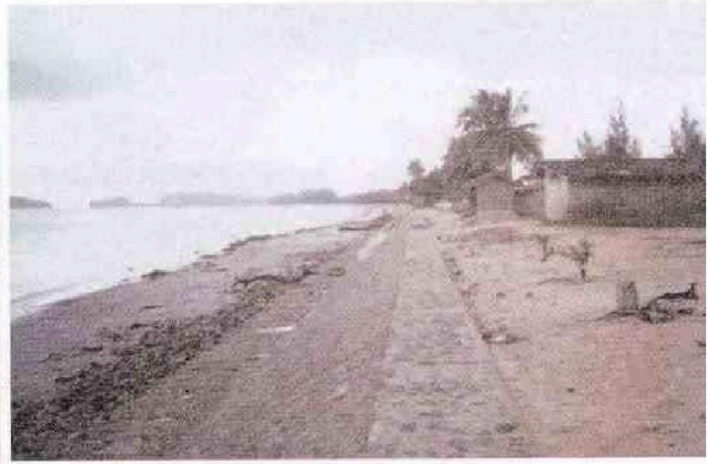
แนวกันคลื่นชายฝั่ง บริเวณหาดปากบารา อำเภอละงู จังหวัดสตูล ในลักษณะกำแพงคอนกรีตเสริมเหล็ก มีหินทิ้งด้านหน้า (ที่มา : หนังสือ "การเปลี่ยนแปลงพื้นที่ชายฝั่งด้านทะเลอันดามัน" ของกรมทรัพยากรธรณี)
