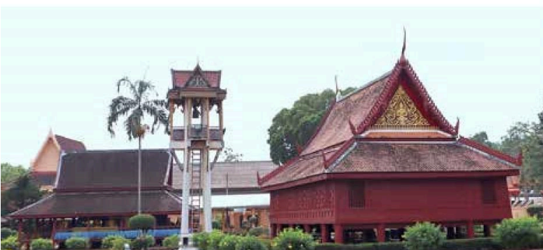
ศาลาการเปรียญไม้ หอระฆัง และหอสวดมนต์
